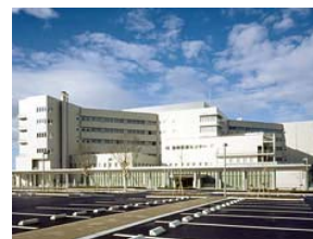
国立病院機構豊橋医療センター
